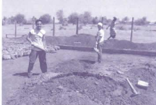
青年センターの建設
