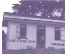
コーヒーの収益金で建設されたグループの事務所
