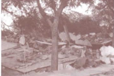
完全に崩壊した学校跡
