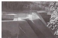
完成後の水門 水はきれいに過濾している
